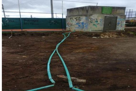
*Trabajos de reparación por vertimiento de agua en túnel oriental de salida al Coliseo, construcción de caja de inspección para control de niveles de agua y rebosamiento. Las aguas que vierten no son del acueducto, ni alcantarillado. Lo anterior de acuerdo al estudio técnico realizado por Emserchía.*
