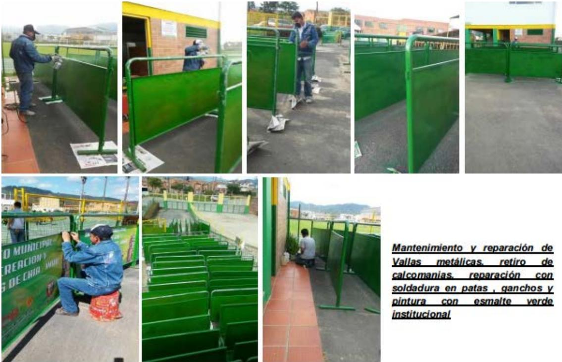
**Mantenimiento y reparación de Vallas metálicas, retiro de calcomanías, reparación con soldadura en patas, ganchos y pintura con esmalte verde institucional.**
